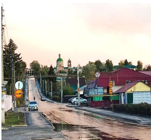
Дорога на ул. Комсомольской после ремонта
